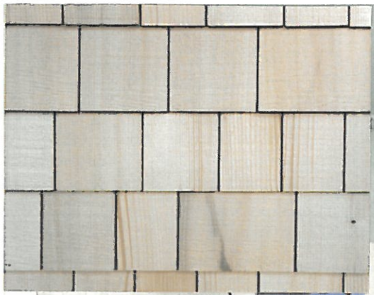
Figur 2: Die Schindeln werden mit rationaler Technik in Handarbeit befestigt.
