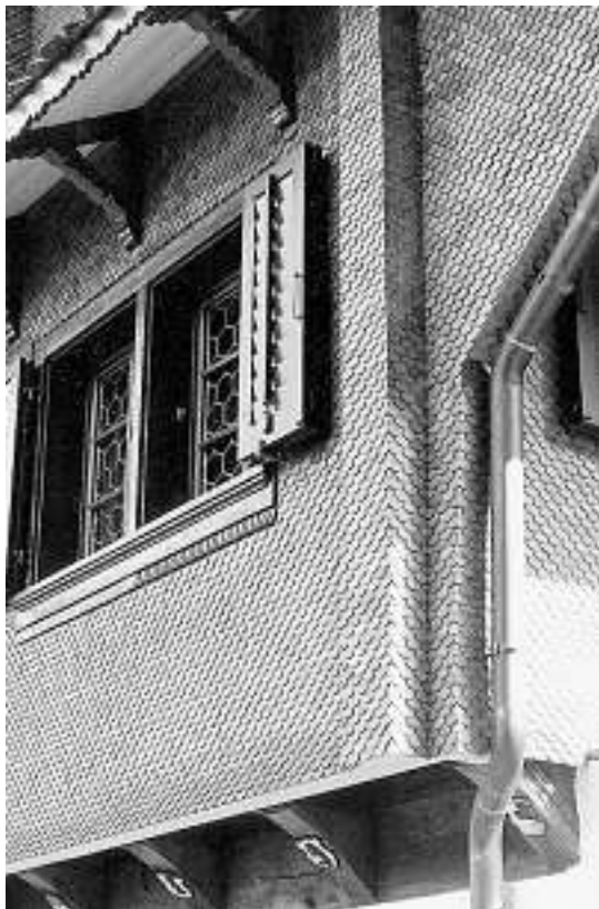
Haus in Ibach Rundschindeln, 60er, \frac{2}{3} Elemente, \frac{1}{3} einzeln
