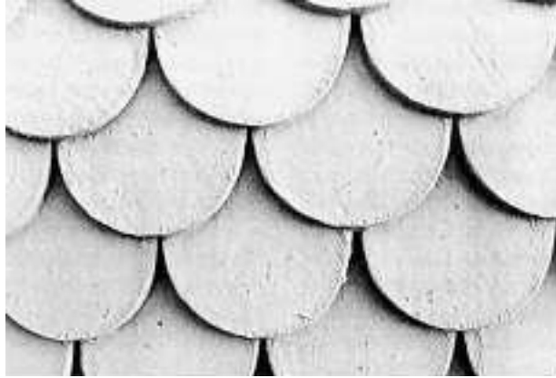
Abb. 3 20-jähriger Ölfarb-Erstanstrich eines Schindelschirms im Appenzellerland
