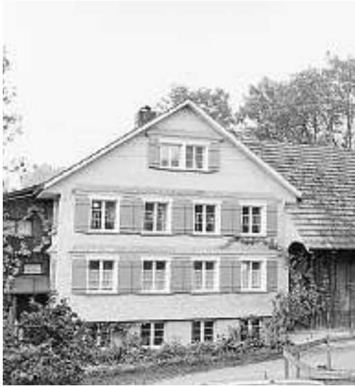
Haus in Niederglatt Rundschindeln 60 mm, 30 mm Fachweite Alle Abschlüsse mit Schindeln ausgeführt; wo möglich, wurde mit Elementen gearbeitet
