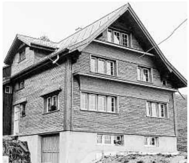
Wohnhaus in Ebnat-Kappel Schindeln handgespalten, 220/70, Schlaufschirm, Fachweite 6 cm
