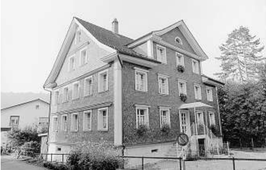
Haus in Wattwil Rundschindeln, 66er-Elemente
