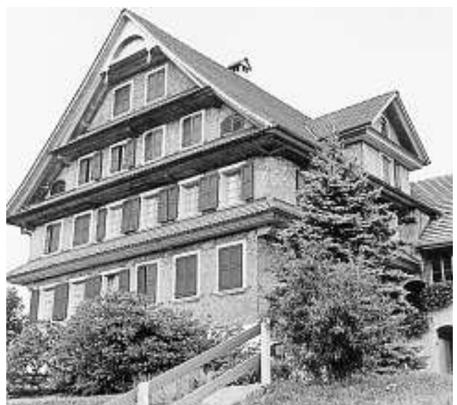
Wohnhaus in Ebnat-Kappel Schindeln handgespalten, 220/70, Schlaufschirm, Fachweite 6 cm
