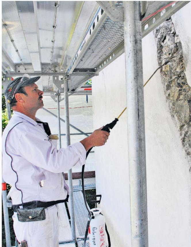
**Marode.** Willy Jossen von der farbe + gips ag bearbeitet einen der konstruktionsbedingten Risse an der Westfassade.
