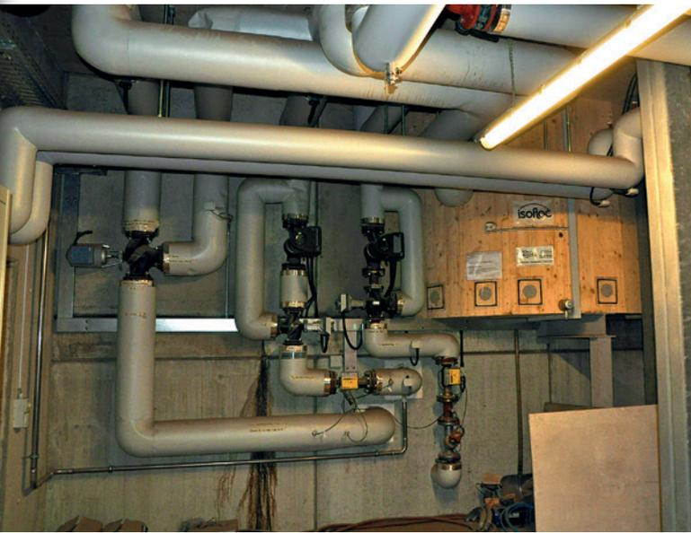
■ Der Wärmepufferspeicher ist derart in der Mitte des Gebäudes zwischen den Räumen für die Holzfeuerungen und die Holzvergaseranlagen eingebaut, dass quasi nur der Boden zu sehen ist.
