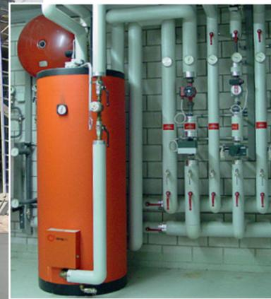
■ Die Wärme wird durch flexible Leitungen verteilt (links). In nur wenigen Häusern gibt es Extra-Wärmepuffer zum Abfangen von Lastspitzen.
