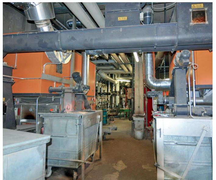
■ Bereits Mitte der 1990er-Jahre wurden zwei Holzhackschnitzelkessel in Betrieb genommen. Im Hintergrund zwischen den Feuerungen sind die Wärmeleitungen zu sehen, die in den Ort führen. Auch die Wärmeleitungen aus den Holzgas-BHKW und dem Notfall-Ölkessel sind hier angeschlossen.
