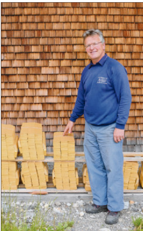
Hansjörg Bucher vor einer Wand, die mit Fichtenschindeln verkleidet wurde.
