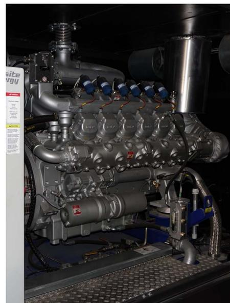
Der mächtige MTU-12-Zylindermotor treibt den Stromgenerator an.
