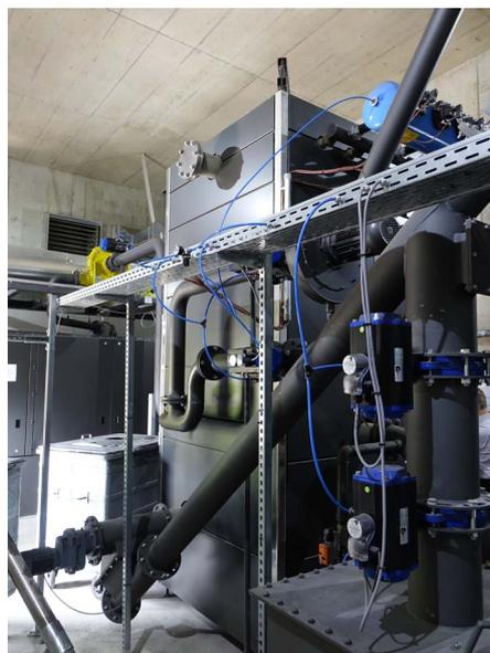
Der Gasfilterturm. Hier wird das Holzgas trocken gereinigt.
